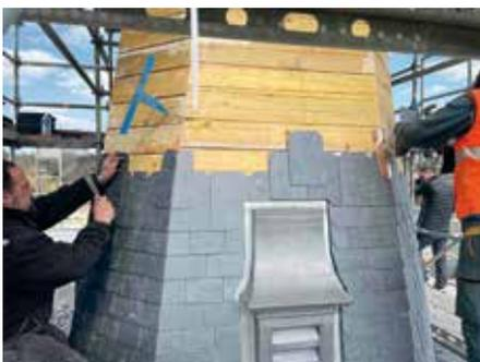
Trois des quatre lucarnes d'horloge sont refaites à l'identique en chêne et la quatrième restaurée et recouvertes entièrement en feuilles de plomb, similairement à la technique plus solide utilisée à la même époque sur le cathédrale Notre-Dame. Il faut en effet noter que lors de la construction originale l'église Saint Médard et pour des raisons de coût, les lucarnes avaient été simplement recouvertes d'une sorte de peintures très épaisses. La porte d'accès au balcon ainsi que le plancher
