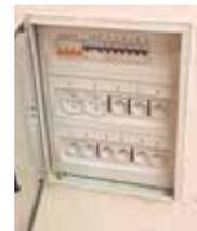
Un nouveau coffret électrique a été installé dans la salle des fêtes (salle aux rideaux) afin d'avoir un maximum de puissance, dans le cas des différentes locations de nos salles (ce travail
