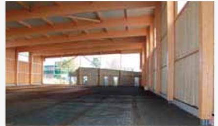
structure des intempéries un bardage bois sera posé à la verticale sur trois cotés, le quatrième recevant un bardage acier.
