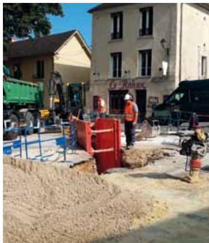
remplacer des canalisations d'eau potable vieillissantes en fibrociment, par des canalisations en fonte. Les techniques de pose sont différentes et les procédures plus longues et contraignantes : essais de pression, désinfection qui nécessitent 3 jours d'attente.
