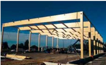
Les travaux ont bien avancé : les fondations ont été coulées (3 m<sup>3</sup> de béton armé) pour supporter les piliers de la charpente. Sur ces fondations, des longrines ont aussi été coulées, afin de recevoir les structures des murs. La charpente a été posée tout récemment. La fin des travaux est prévue au mois de mai 2017.
